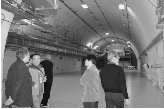
図3 FEH の内部。トンネルの内寸は幅15 m、長さ80 m、高さ10 mあり、SCSS 試験加速器を5セット以上並べることが可能である。
